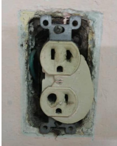
Imagen 1: Tomacorriente quemado por el uso de calentadores eléctricos. Fuente: Imagen tomada por los autores
