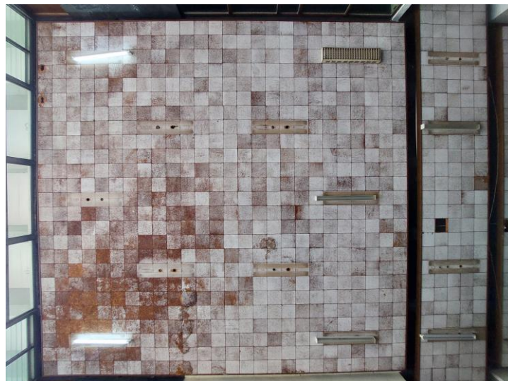
Fig. 9. Falso techo de bagazo de caña ubicado en el rectorado. Fuente: autor.
