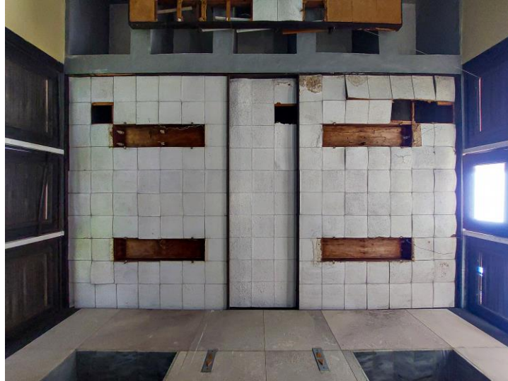
Fig. 8 Falso techo de bagazo de caña ubicado en el segundo piso de la actual Facultad de Ingeniería Industrial, en frente de los elevadores. Se puede apreciar su buen estado de conservación y la ausencia de las luminarias originales. Fuente: autor.
